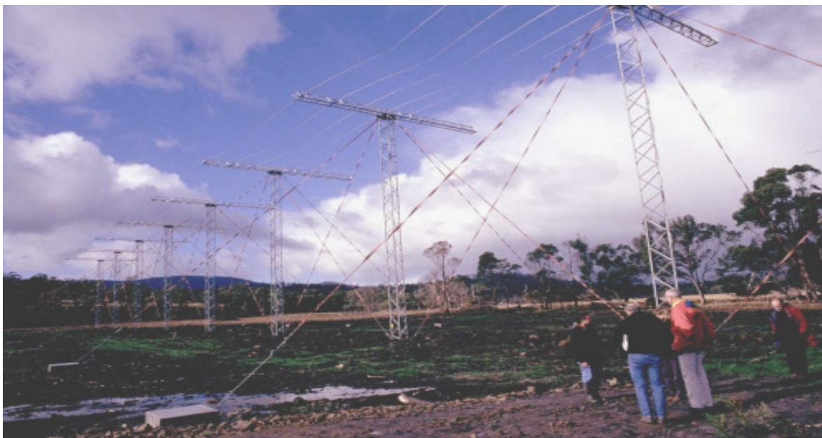
Abb. 3: Die 16 und 4 Log-Periodic-Antennen des Ionosphären-Radars, Insel Bruny, Tasmanien, Australien
